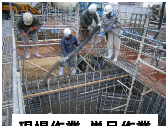
現場作業・単品作業
