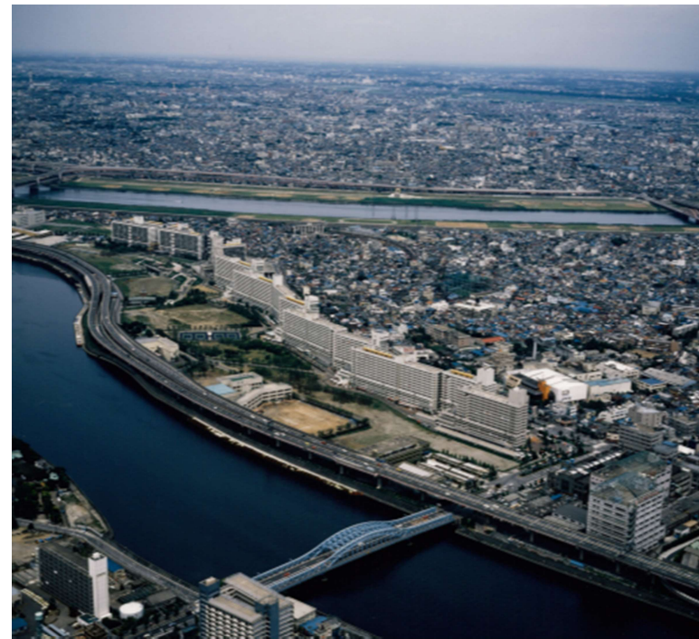
白鬚東防災団地の建設(1971-1986)
