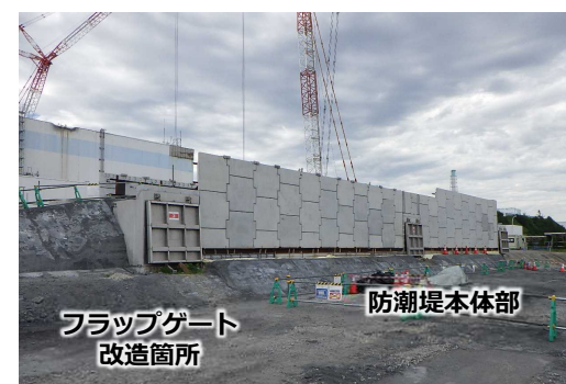
【写真②】北側防潮堤本体構築中（2022.8）
