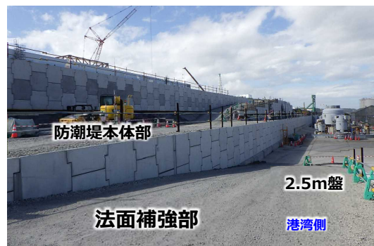
【写真①】防潮堤本体施工中（2022.9）
