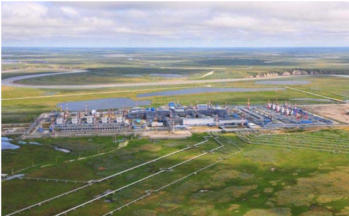
ロシア北部ヤマロ・ネネツ自治管区に建設された天然ガス生産施設 = 2020年5月、ガスプロム提供
