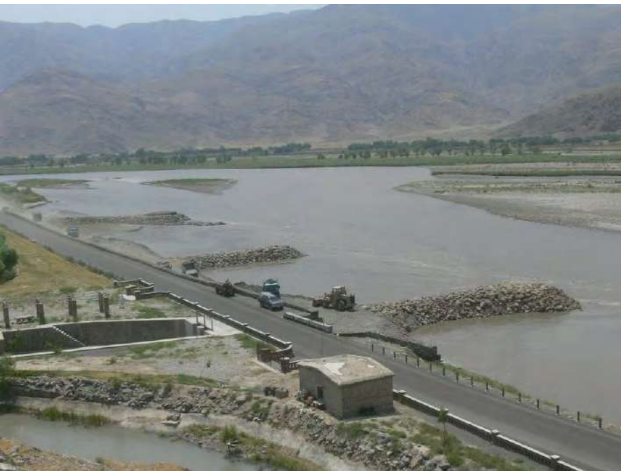
石出し水制（クナール河）用水路 Canal from Kunar River
