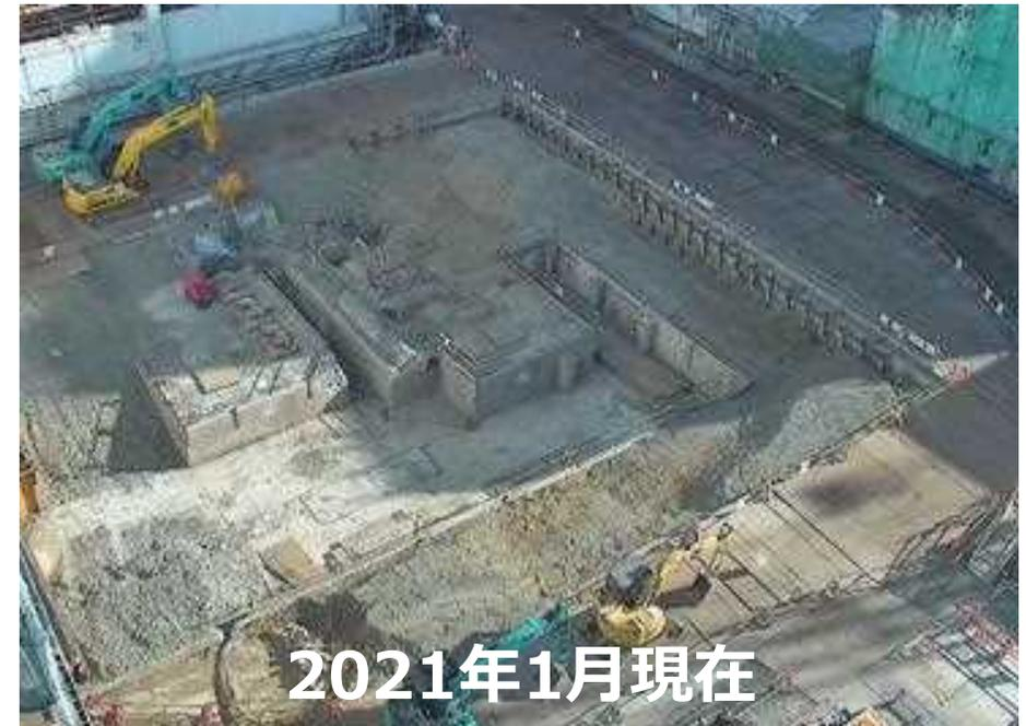
構台設置エリアの埋設物撤去工事を実施
