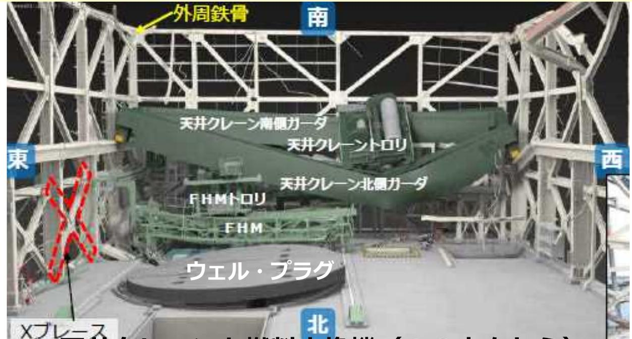
天井クレーンと燃料交換機（Aの方向から）
