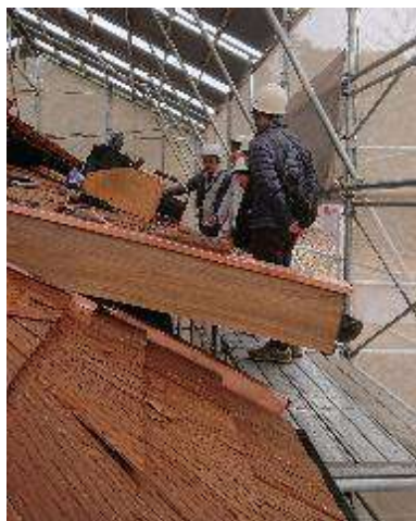
建造物修理現場公開イメージ
