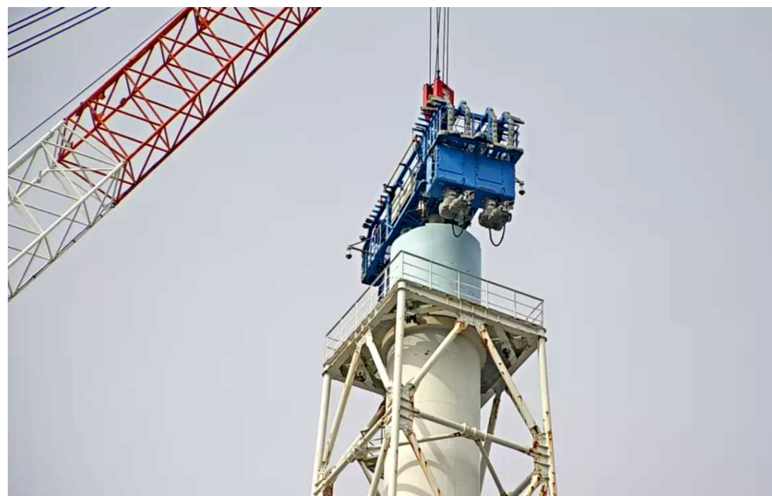
地元企業による廃炉作業への参画 「1 / 2号機排気筒解体」(2019.8.1～)
