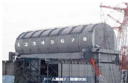
3号機ドーム屋根設置完了
