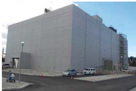
雑固体廃棄物焼却設備
