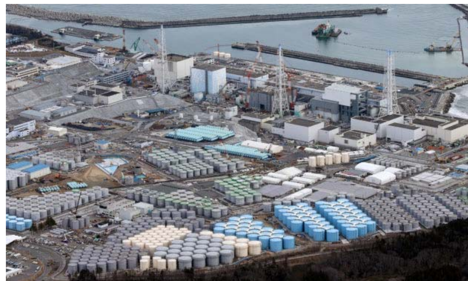
【1F構内に広がるALPS処理水タンク】
