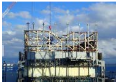
1号機建屋カバー取り外し完了
