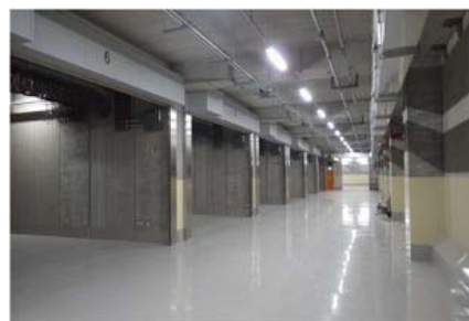
固体廃棄物貯蔵庫第9棟
