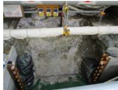
凍土壁の造成状況確認
