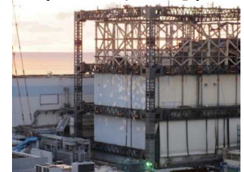
パネル撤去完了 (2016年11月)
