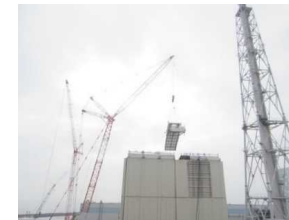
屋根パネルの撤去 (2015年7月)
