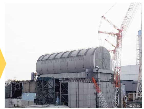
ドーム屋根の設置
