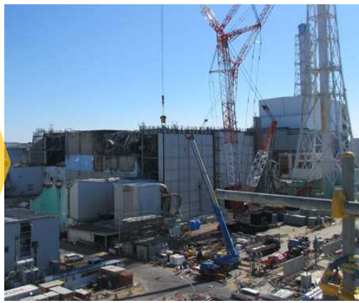
大型ガレキ撤去後
