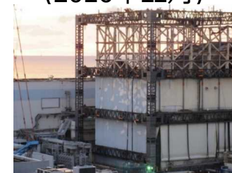
パネル撤去完了 (2016年11月)
