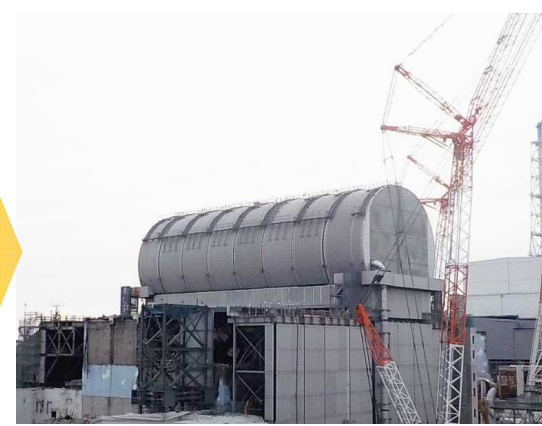
ドーム屋根の設置
