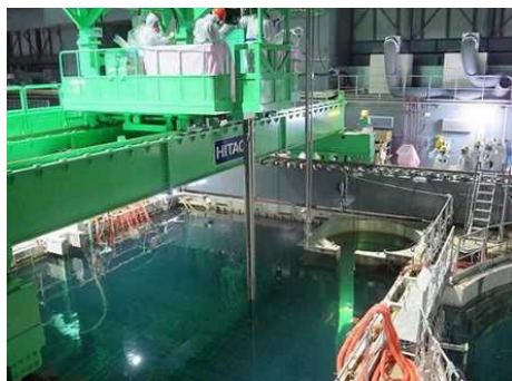
4号機燃料の取出し状況
