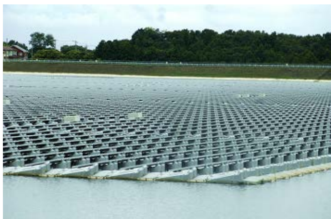
ダム水面に設置された太陽光パネル
