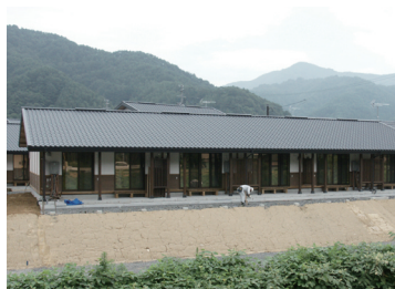
大ヶ口地区の災害公営住宅
