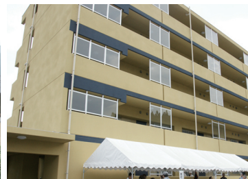
吉里吉里地区の災害公営住宅
