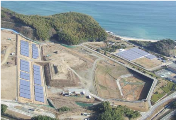
大原百万千瓦级太阳能发电站全景（福冈市消防局提供）
